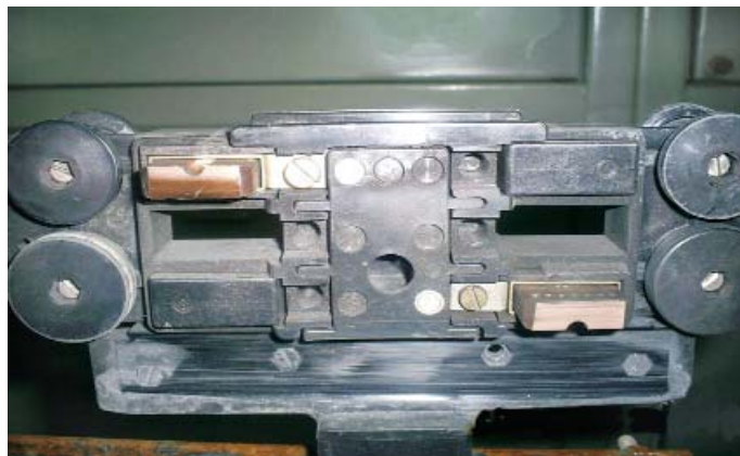
Рис. 4. Внешний вид токосъемника для шинопроводов семейства LSV
